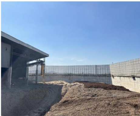
รูปที่ 11 การติดตั้งตาข่ายรอบบริเวณลานกองเก็บขานอ้อย
