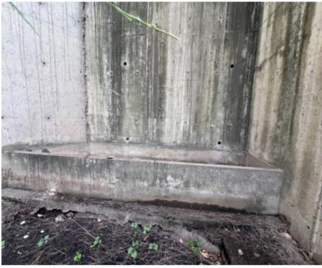
รูปที่ 9 รางระบายน้ำล้อมรอบลานกองเก็บขานอ้อย
